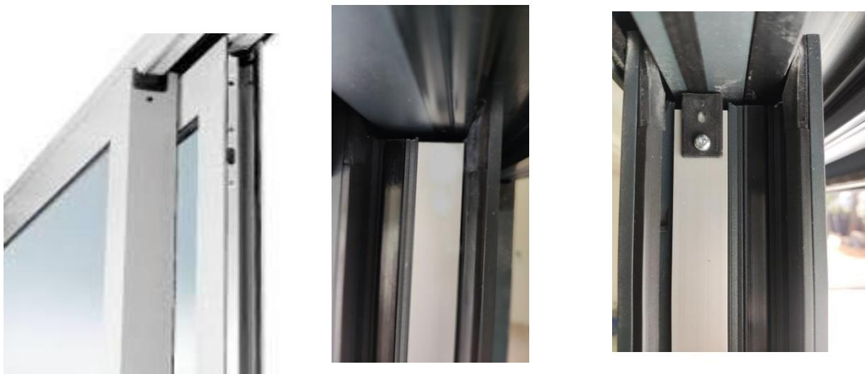
Σε περίπτωση που ο μαγνήτης δεν χωράει μεταξύ συρόμενου φύλλου και κάσας, κάντε στο ανώτερο σημείο του μηχανισμού μία τρύπα 9mm εικόνα 7 και τοποθετήστε όπως φαίνεται στην εικόνα 8.
