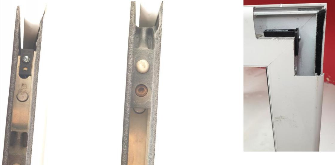
Σε συρόμενα ανασυρόμενα όπου ο μηχανισμός της κλειδαριάς σκεπάζει τη κοιλότητα του κουφώματος εικόνα 4 και 5, τοποθετήστε τον μαγνήτη όπως φαίνεται στη εικόνα 6.
